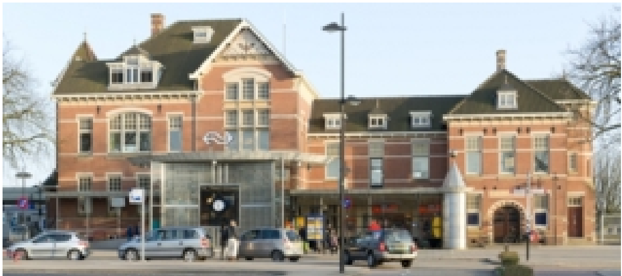
Station Woerden wordt door groep 7/8 op de maquette nageemaakt.
